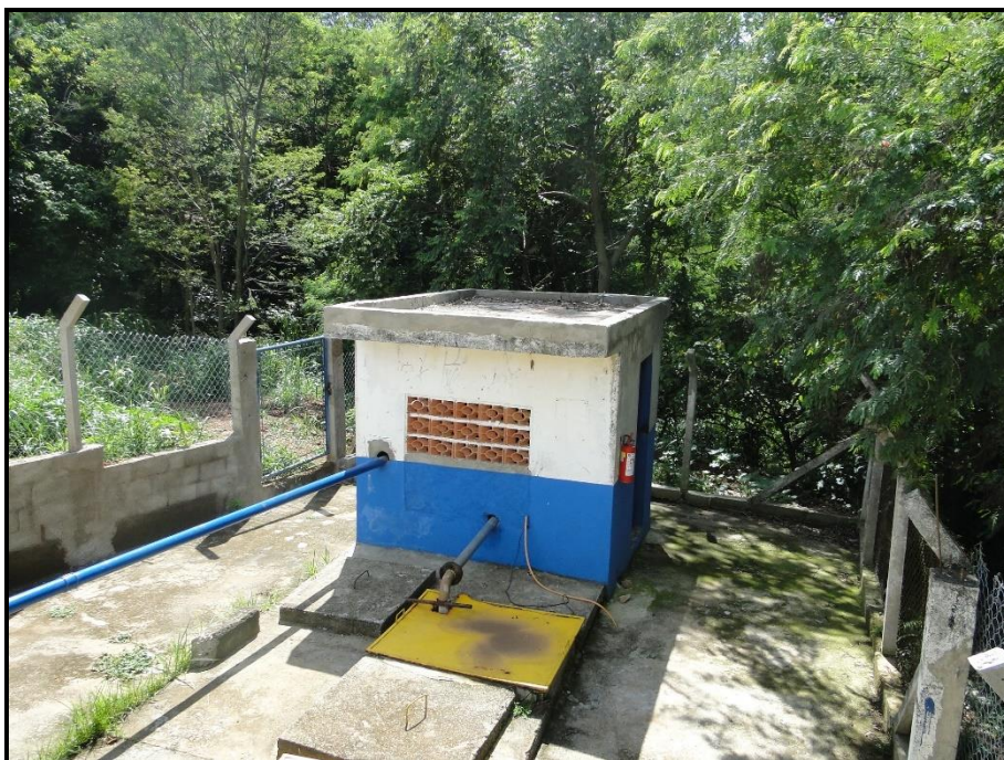
Figura 64 - Estação elevatória de esgotos Lulinha
