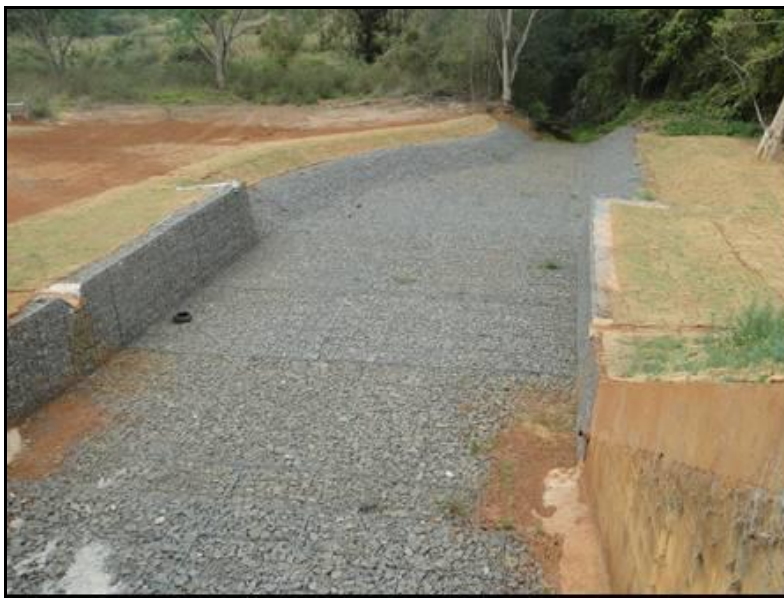
Figura 12 - Reforma do vertedouro da represa
