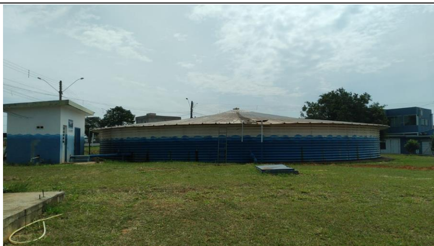
Reservatório Sacilotto II
