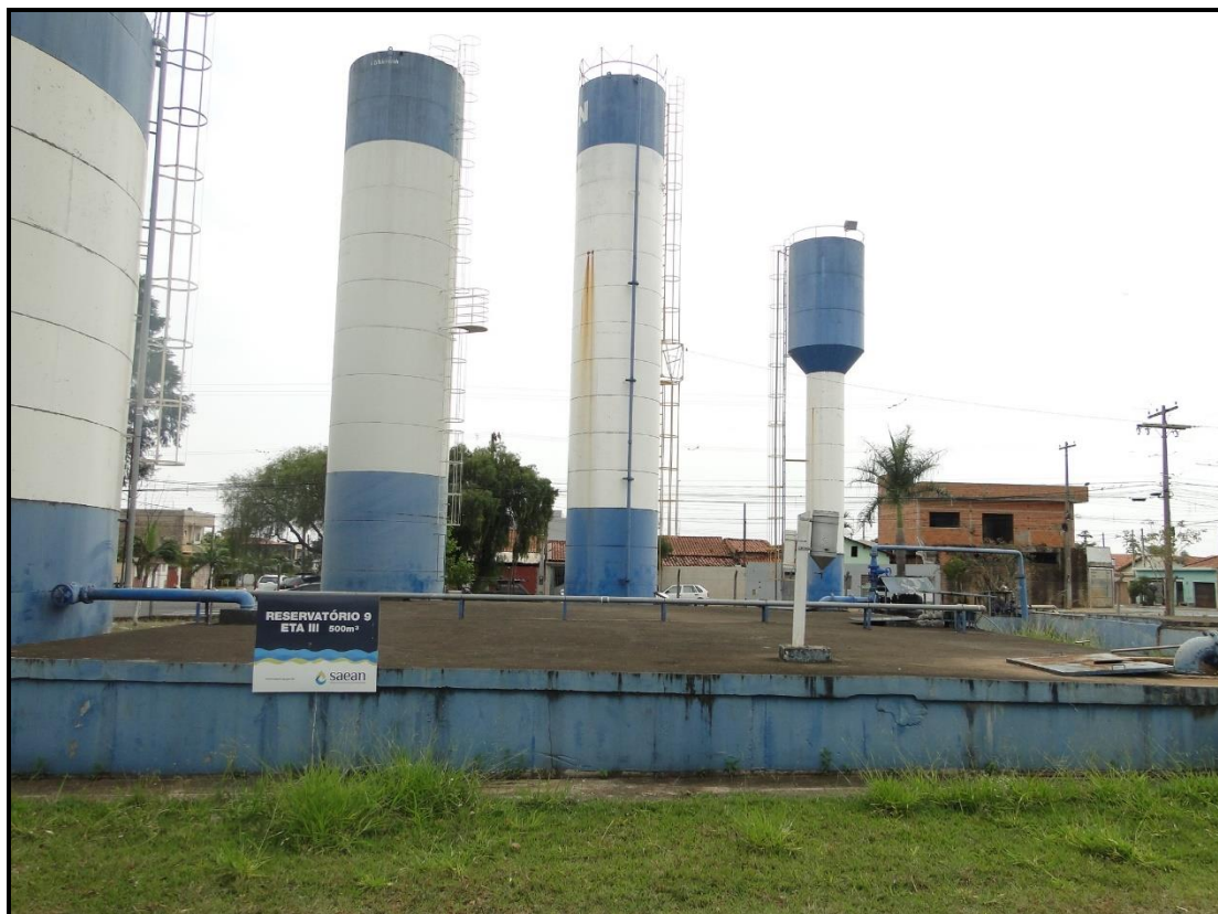
Figura 55 - Reservatório enterrado da ETA III
