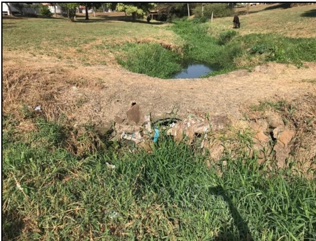
Figura 119 - Travessia (TR 05) próximo à Rua Ângelo Tebaldi.
