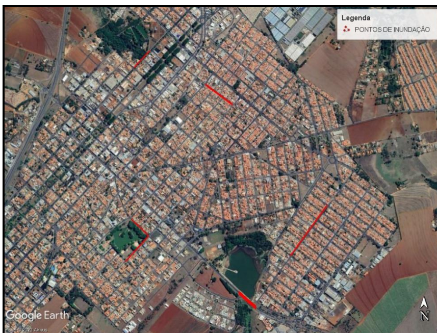
Figura 138 - Principais pontos de inundação no município de Artur Nogueira.
