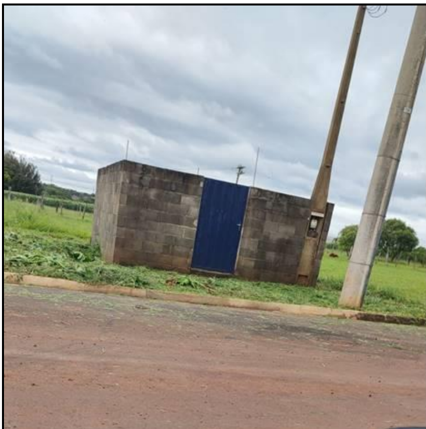
Figura 75 - Estação elevatória de esgotos Conquista
