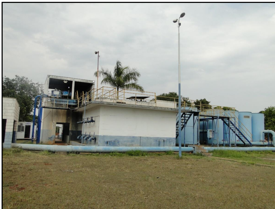
Figura 33 - Estação de Tratamento de Água III
