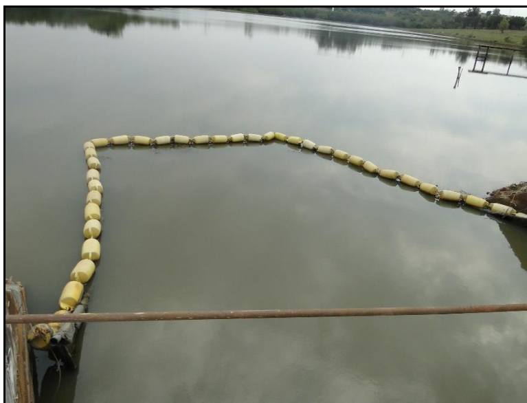
Figura 16 - Barreira para contenção de poluição superficial da represa
