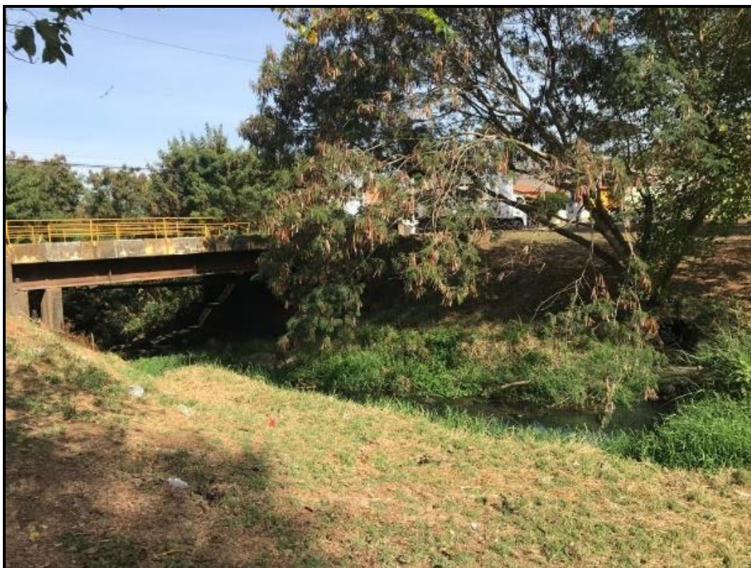
Figura 121 - Travessia (TR 07) na Rua João Francisco Barbosa
