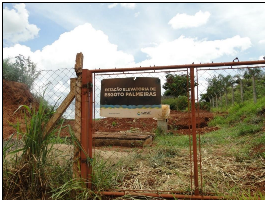
Figura 71 - Estação elevatória de esgotos Palmeiras
