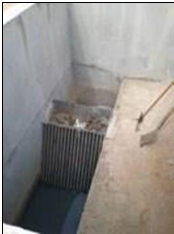
Figura 76 - Gradeamento
