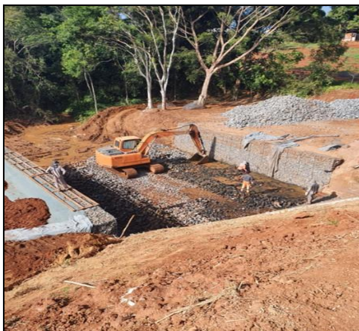
Figura 11 - Reforma do talude da represa
