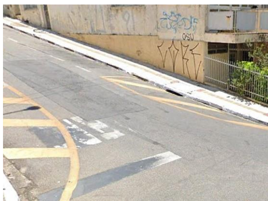
Figura 131 - Boca de lobo de guia simples sem depressão.
