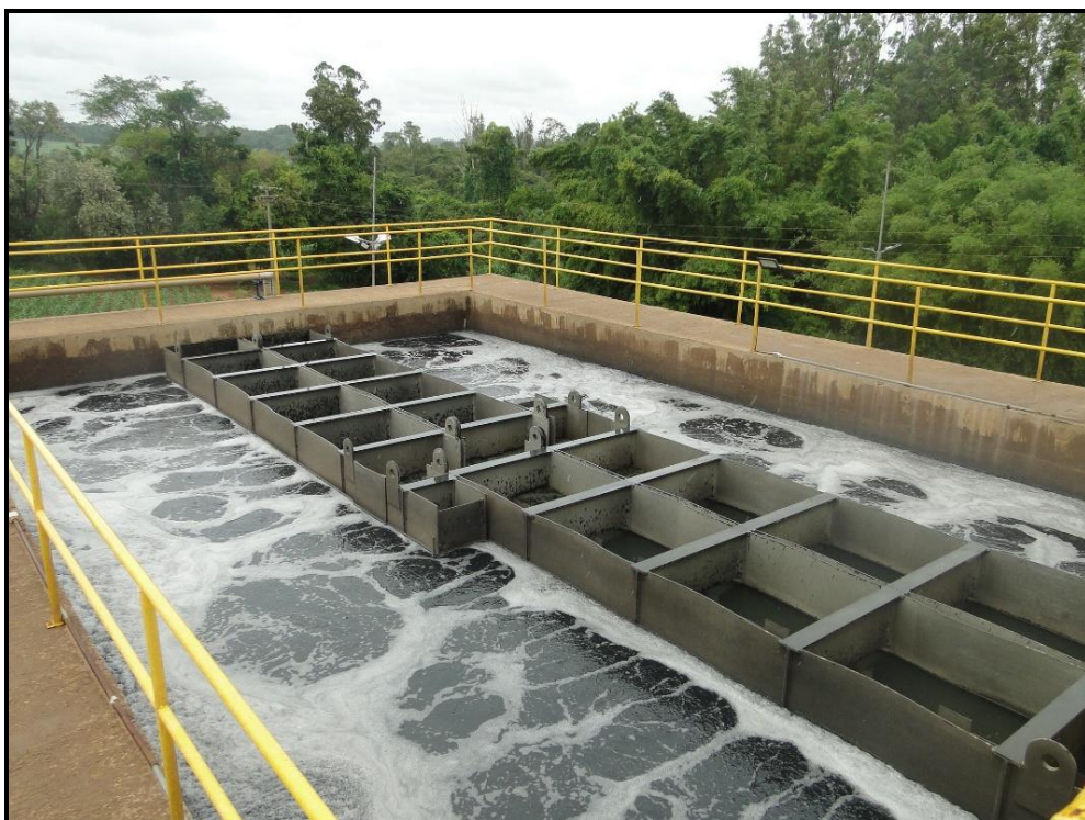
Figura 94 - Tanque de contato para desinfecção e calha Parshal de saída
