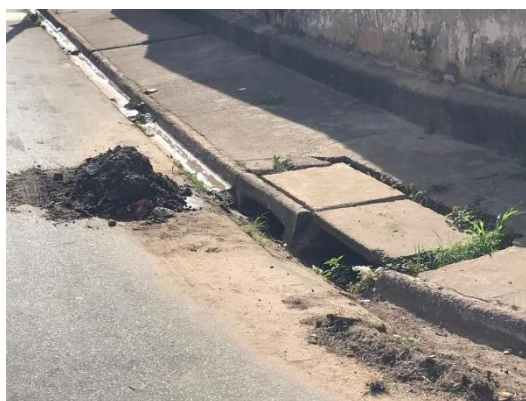
Figura 132 - Boca de lobo de guia dupla sem depressão.
