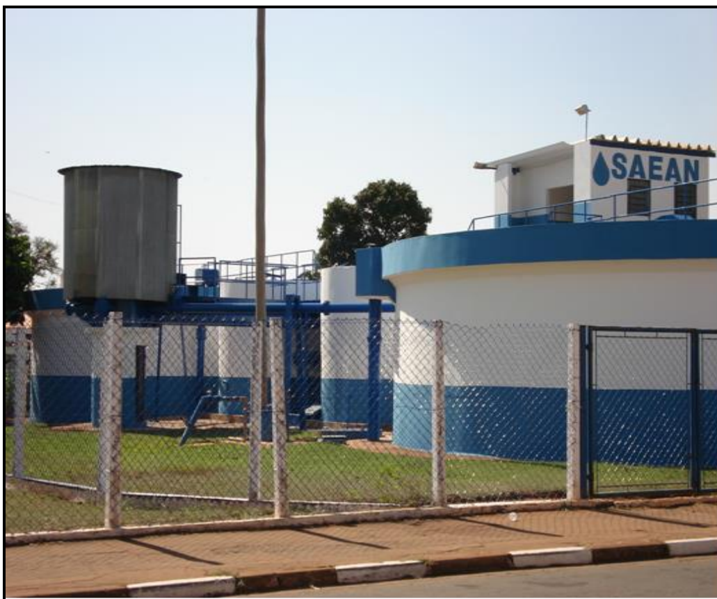
Figura 24 - Estação de Tratamento de Água II
