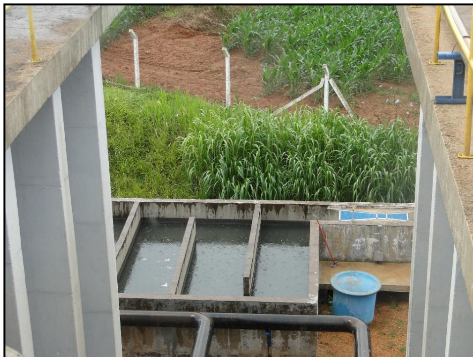
Figura 94 - Tanque de contato para desinfecção e calha Parshal de saída
