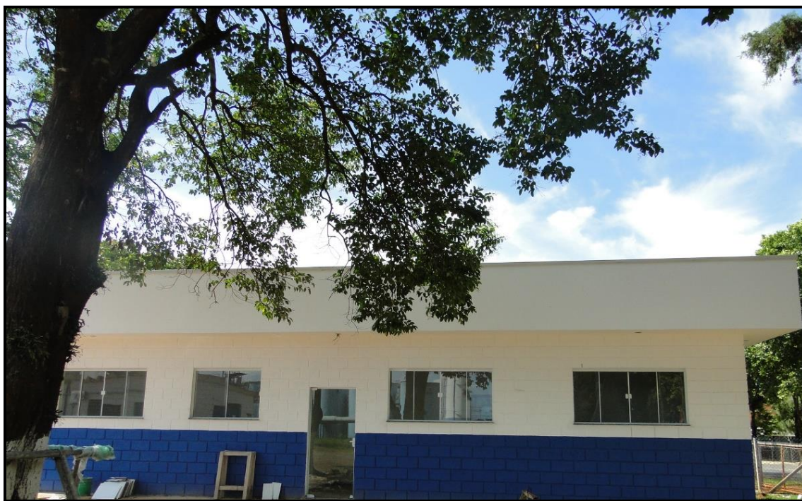
Figura 45 - Laboratório de Controle de Qualidade em construção
