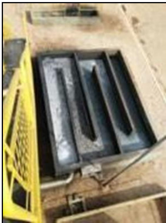
Figura 82 - Chicana de desinfecção
