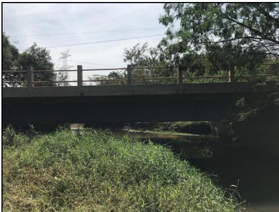
Figura 123 - Travessia (TR 09) na Rodovia José Santa Rosa
