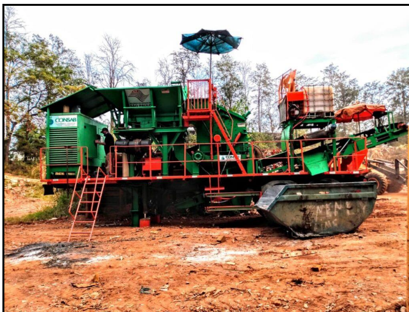
Figura 104 - Britador de RCC
