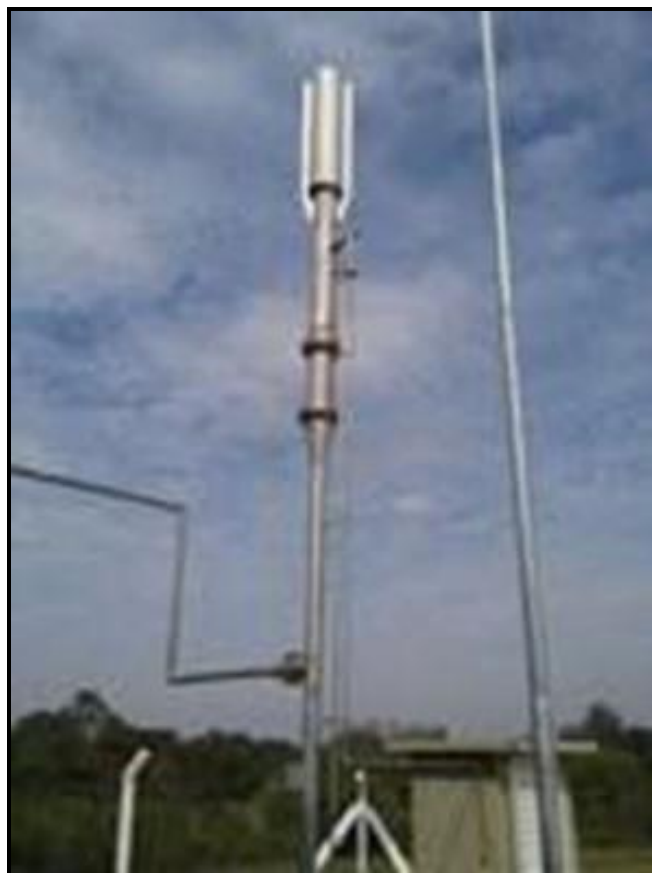
Figura 84 - Queimador de gases - Flare
