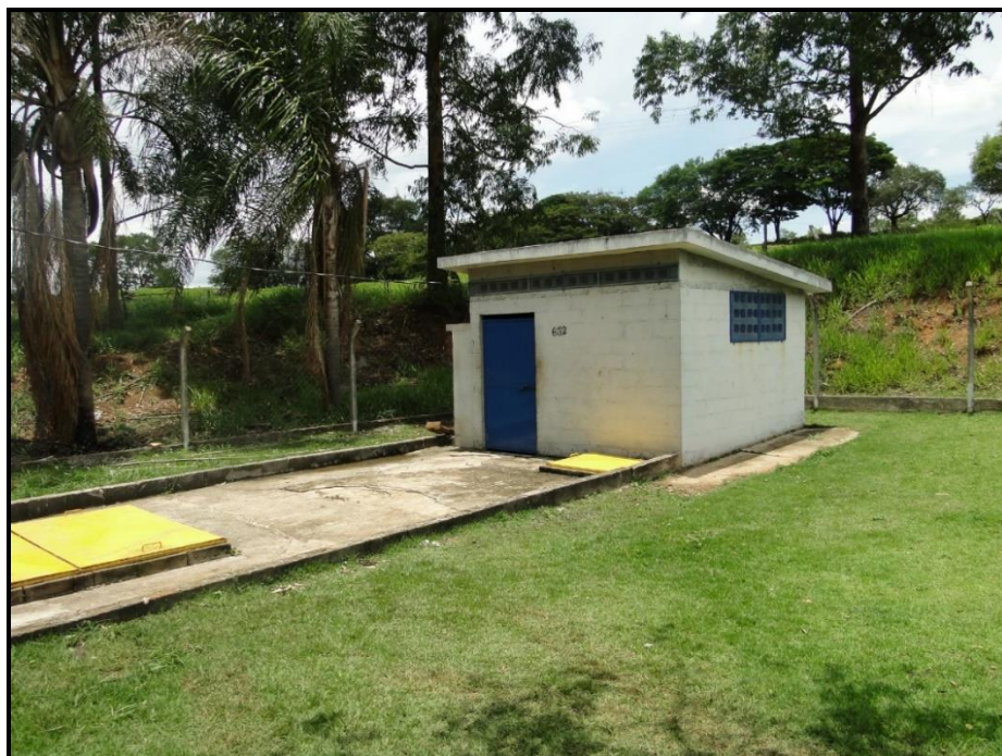
Figura 70 - Estação elevatória de esgotos Parque dos Ipês
