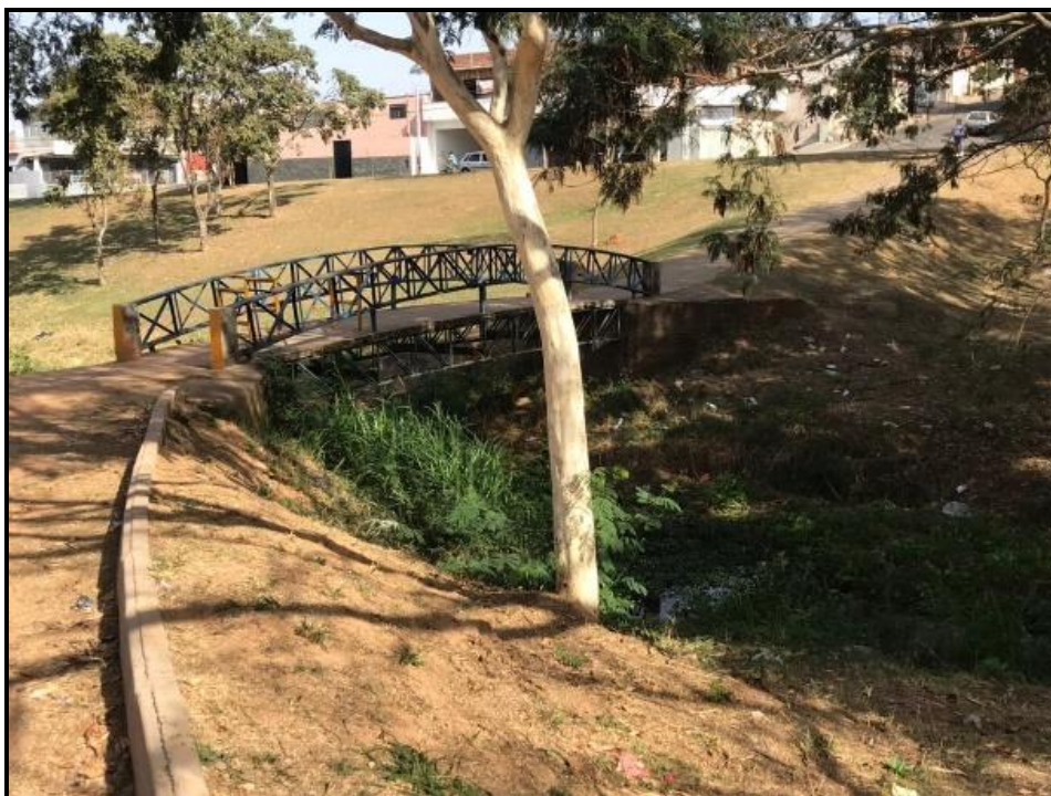
Figura 118 - Travessia (TR 04) próximo à Rua Antônio da Cunha Claro.
