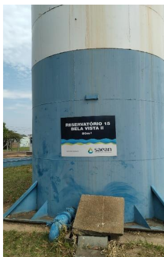
Reservatório Bela Vista
