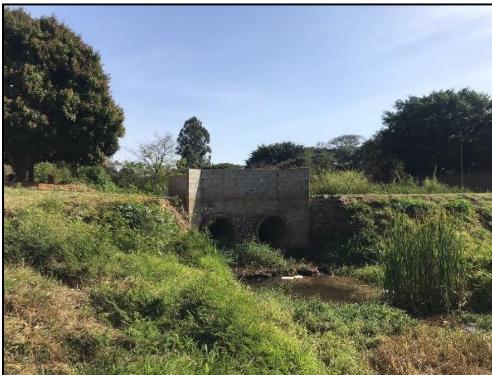
Figura 116 - Travessia (TR02) na Rua Manoel Rodrigues Junior.
