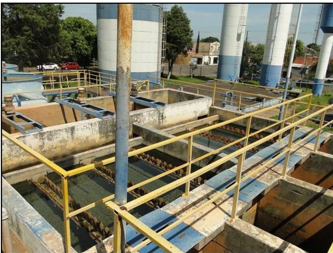
Figura 35 - Floculadores, decantadores e filtros da primeira de construção
