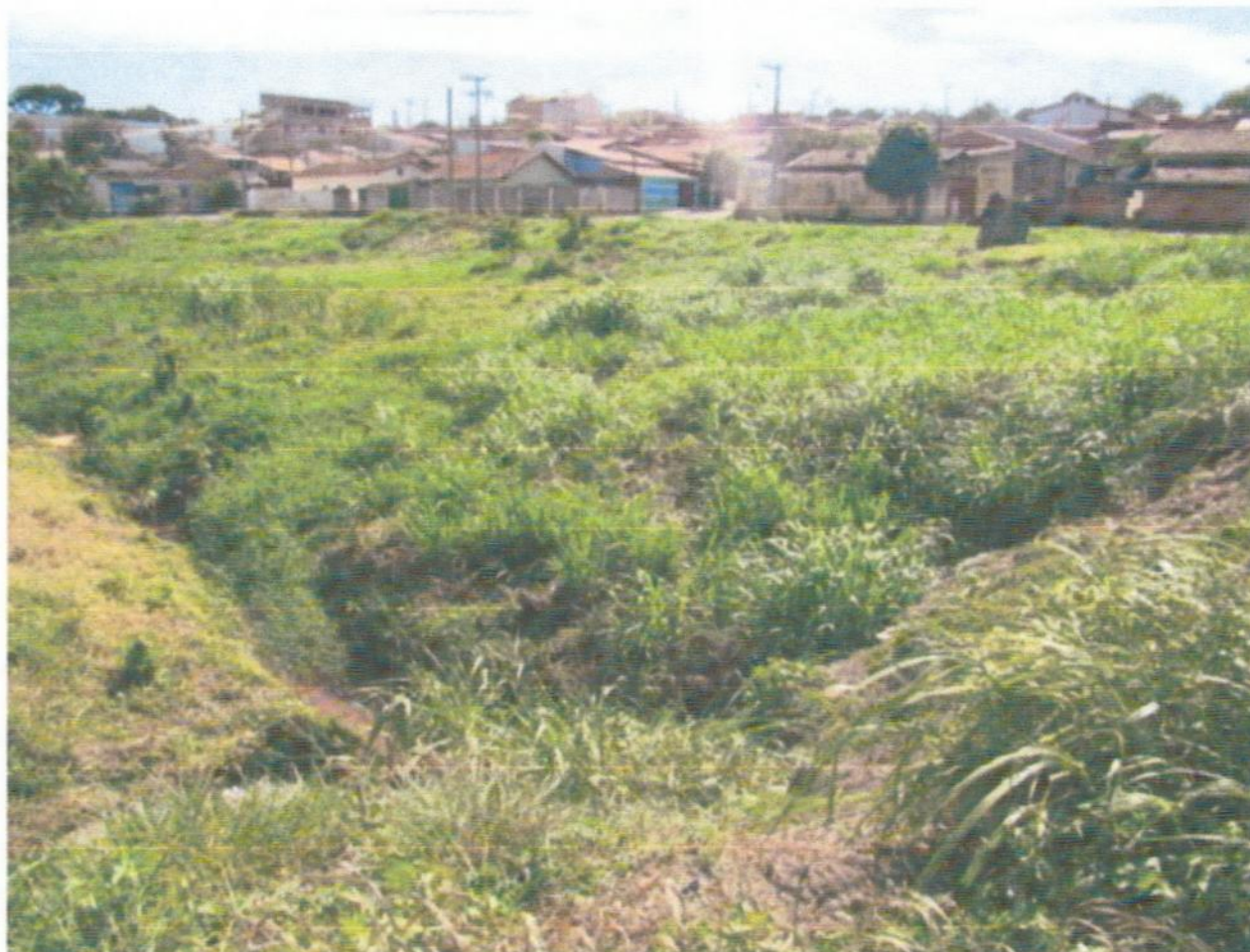
Figura 08: Subdimensionamento dos rios com tubulações de diâmetro pequeno dificultando a vazão em épocas de alta pluviosidade. Rio Cotrins - Artur Nogueira.
