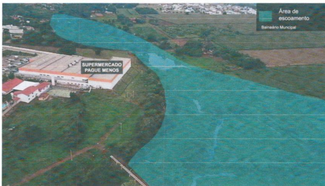
Figuras 11 e 12: Área no entorno do Balneário Municipal, demarcada como área de constante alagamento, devido à subida do nível da lagoa nos períodos chuvosos e falta de escoamento das ruas do entorno. Há risco de rompimento da barragem do balneário, podendo provocar danos à Avenida Fernando Arens no entorno do balneário.
