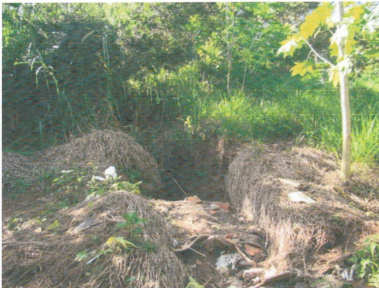
Figura 06: Erosão causada pelas águas pluviais (chuvas)
